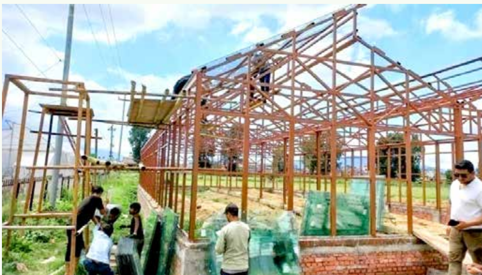
चित्र २: सिसा घर निर्माण गरिदै
